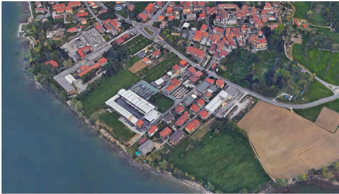
Stato attuale (google maps)
