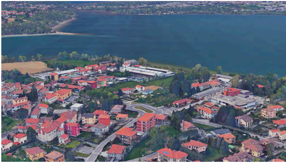
Stato attuale (google maps)
