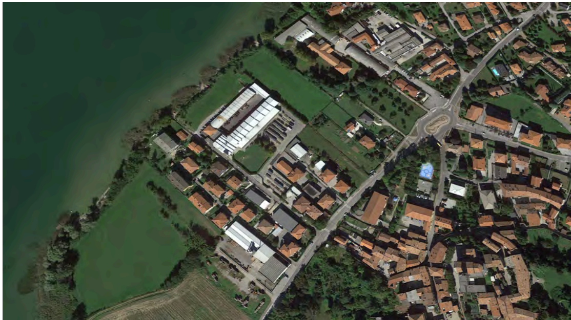
Stato attuale (google maps)
